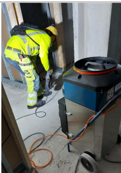
Figur 3-9. Mobil luftrenser anvendt ved brugen af trykluft-hammer (fra Tuomi et al. 2023).
