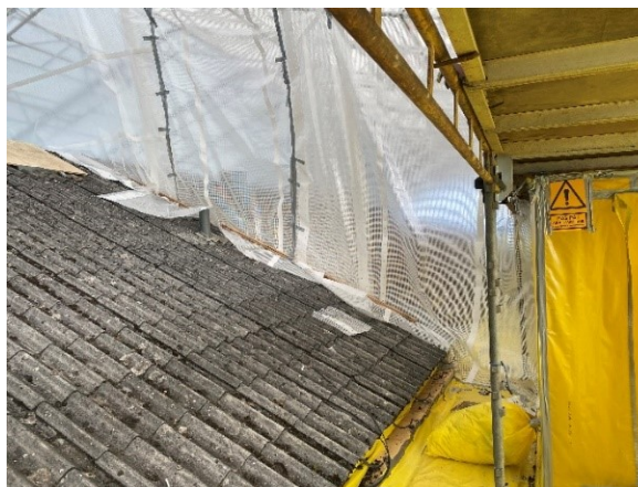
Billede 4—4. Eksempel på arbejdsområde med fuld overdækning set fra adgang til trekamret sluse
