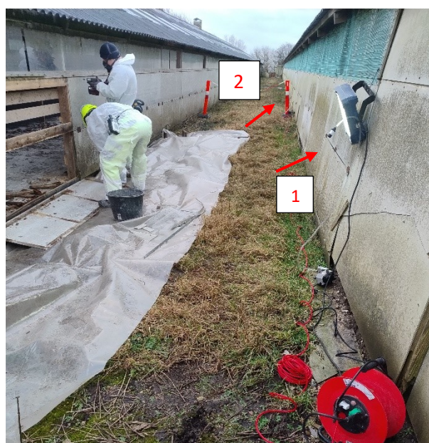
Billede 4—21. Placering af stationære målinger på minkfarm projekt 4. Målingerne er placeret langs den ene side af facaden hvor arbejdet foregik.
