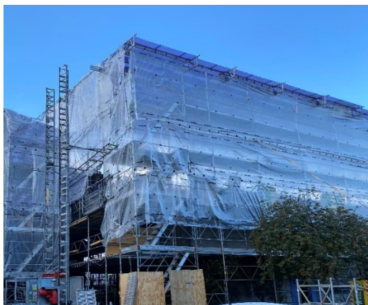
Billede 4—3. Eksempel på fuld overdækning set udefra
