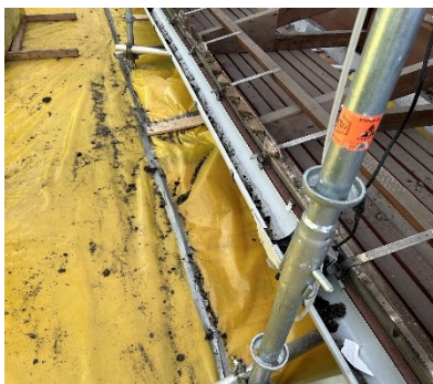
Billede 4—12. Støv og asbestholdig mos på trods af skånsom håndtering
