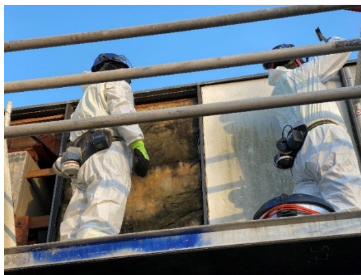
Billede 4—2. Nedtagning af facadeplader fra et rullestillads.
