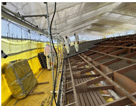
Billede 4—11. Skånsom håndtering af asbestplader
