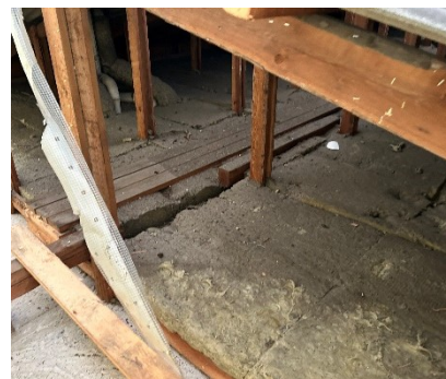
Billede 4—13. Større mængder af støv under tagpladerne på overfladen af isolering
