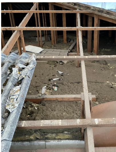
Billede 4—9. Arbejdsområde – meget støv på isolering. Knækkede plader og mos på asbestplader – dette er et generelt gængs billede på alle typer projekter.
